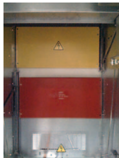
Compartiment disjoncteur
